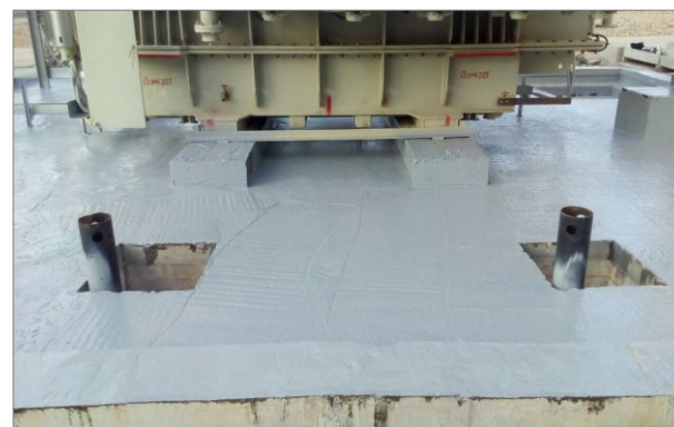
Гидроизоляция бетонных конструкций ОАО «Концерн Росэнергоатом». г. Удомля, 2016 г.
