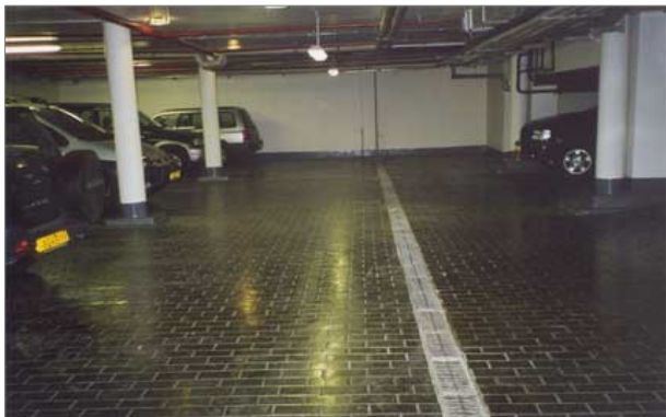
Обеспыливание полов паркинга банковского хранилища. г. Москва. 2000 г.
