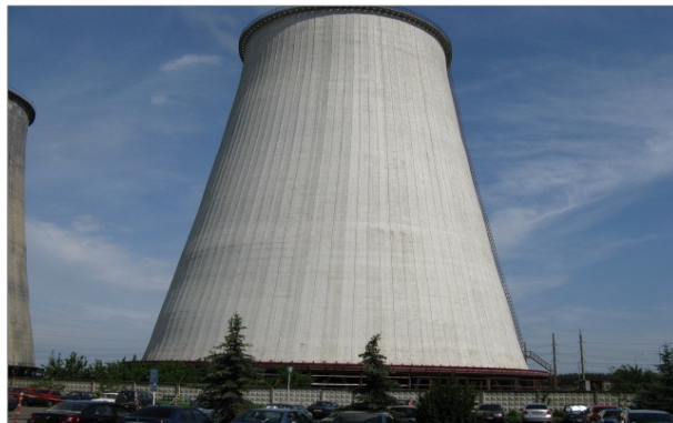
Внутренняя гидроизоляция градирни на ТЭЦ-6, АК «Киевэнерго». г. Киев. 2000 г.
