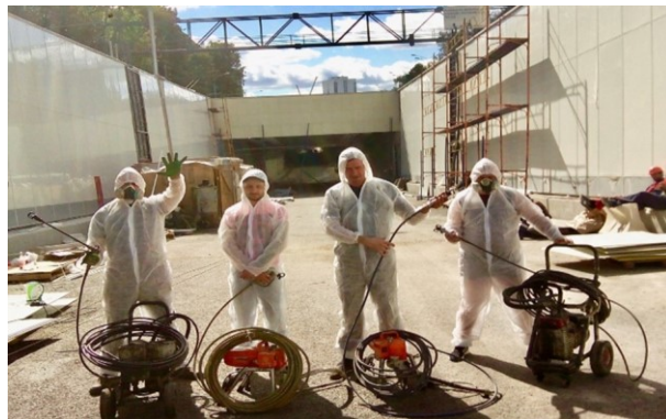
Гидроизоляция тоннеля развязки на пересечении МКАД и Ленинского проспекта. г. Москва. 2016 г.
