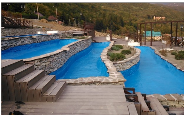
Гидроизоляция каскада водопадов. Санаторий «Беларусь». г. Сочи, п. Красная Поляна. 2015 г.
