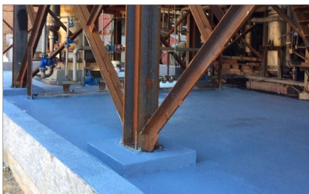
Химстойкое покрытие бетонных конструкций. ОАО «Щекиноазот». г. Новомосковск. 2016 г.
