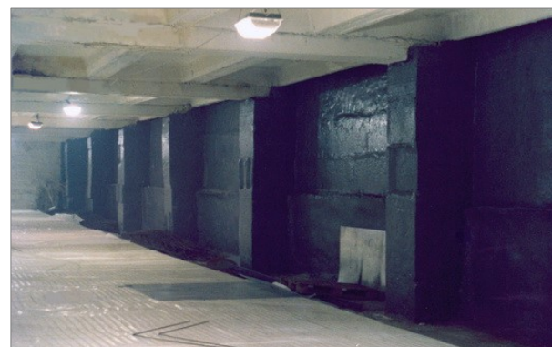
Гидроизоляция подземных хранилищ складского комплекса ЗАО «Сетунь». г. Москва. 2002 г.
