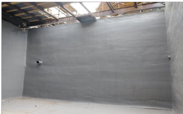
Гидроизоляция бассейна нейтрализации ПАО «Тольяттиазот». г. Тольятти. 2019 г.
