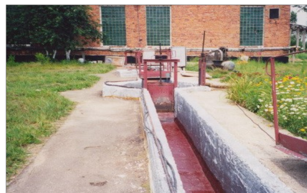
Защитное покрытие очистных сооружений завода удобрений АО «Акрон». г. Дорогобуж. 2002 г.
