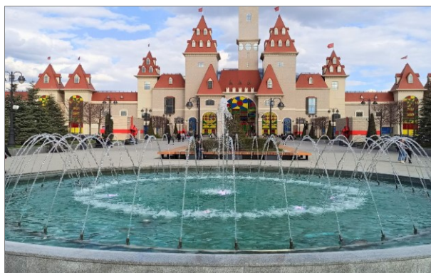
Гидроизоляция уличных фонтанов. ТЦ «Остров мечты». г. Москва. 2020 г.
