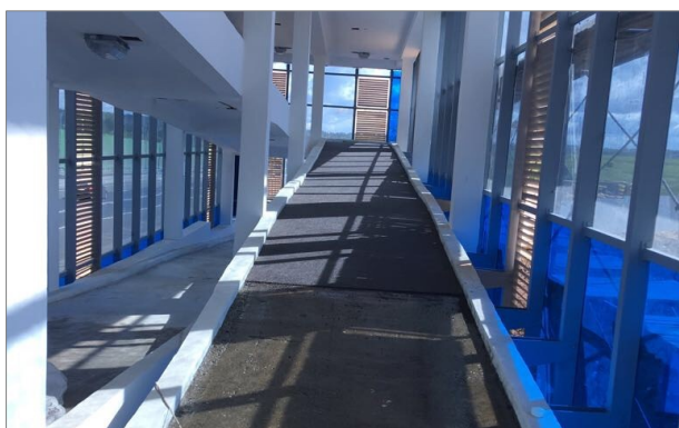
Кварцнаполненное покрытие полов пешеходного перехода. Калужское шоссе, Моск. обл. 2018 г.
