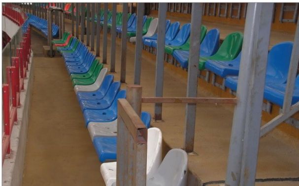
Защита бетона трибун стадиона «Локомотив». г. Москва. 2006 г.
