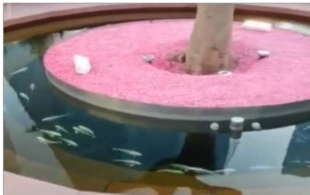
Гидроизоляция бетонных конструкций. Парк Галицкого. г. Краснодар. 2020 г.
