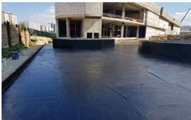
Гидроизоляция бетонных конструкций ТЦ «Галеон». г. Москва. 2017 г.
