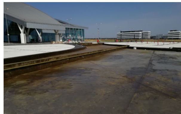
Гидроизоляция бетонных конструкций аэродрома Платов. г. Ростов-на-Дону. 2018 г.
