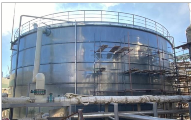
Гидроизоляция металлического резервуара. ПАО «Тольяттиазот». г. Тольятти. 2021 г.
