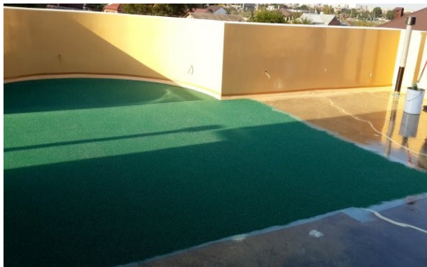
Наполненное кварцевым песком покрытие террасной кровли. г. Краснодар. 2015 г.
