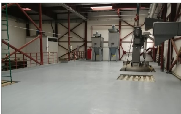
Устройство полимерных кварцнаполненных полов. Завод «Хенкель». г. Коломна. 2021 г.
