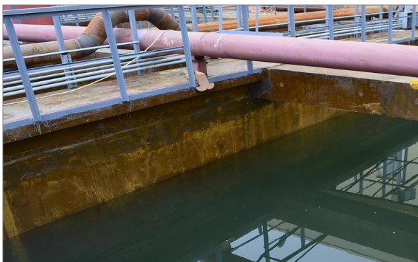
Ремонт и гидроизоляция очистных сооружений. МО, г. Балашиха. 2014 г.
