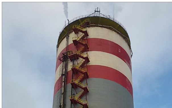
Ремонт грануляционной башни карбамида. ОАО «Тольяттиазот», г. Тольятти. 2014 г.
