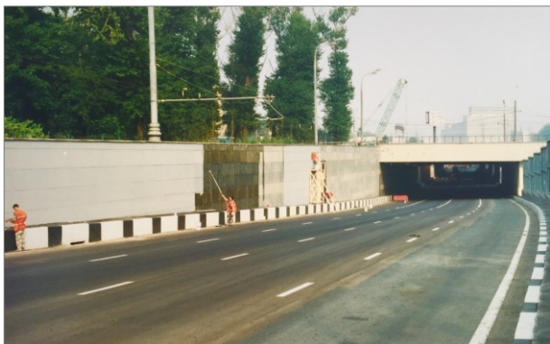
Защита и гидроизоляция бетона. ТТК, Нахимовский тоннель, г. Москва. 2002 г.
