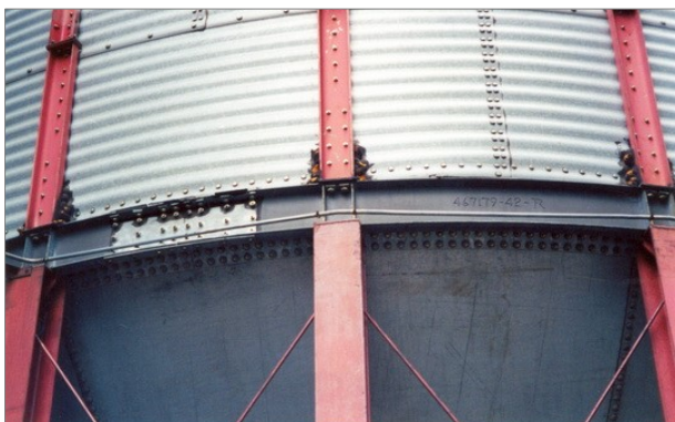
Герметизация металлических силосов пивзавода «Efes Pilsener». г. Москва. 2001 г.
