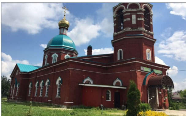
Защита кирпичных и деревянных конструкций храма Святой Троицы. Липецкая обл. 2015 г.
